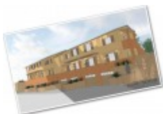
Cantiere Buti - Foto 8
