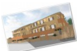
Cantiere Buti - Foto 9
